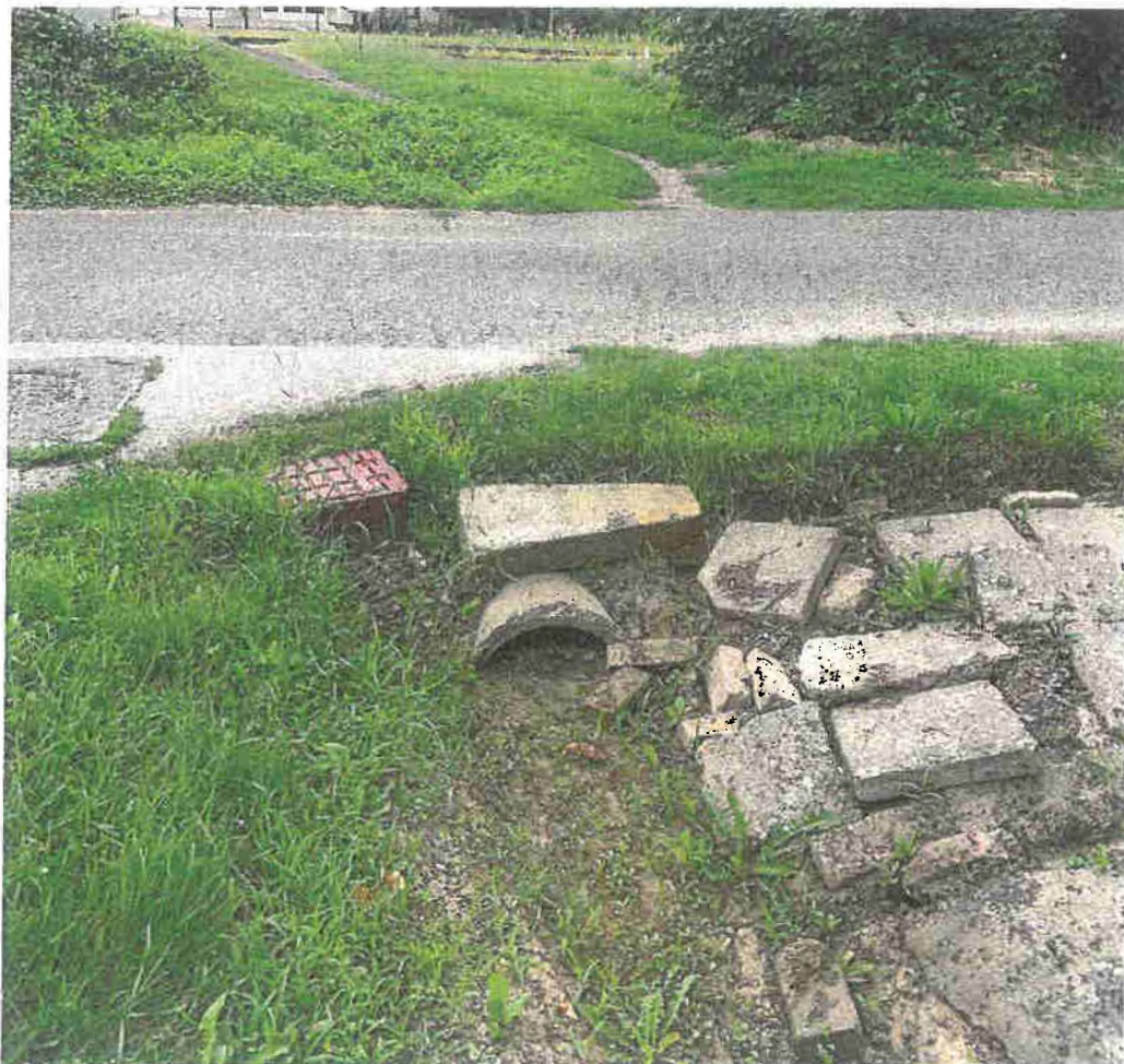
A lezúduló csapadék következtében hordalékkal telített átesz
